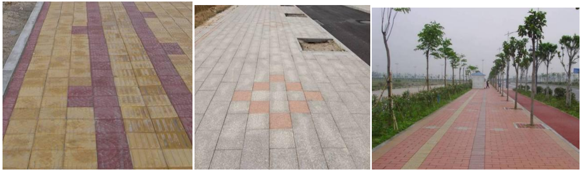
普通水泥砼道板砖人行道实景图花岗岩道板砖人行道实景图彩色环保型透水砖人行道实景图
