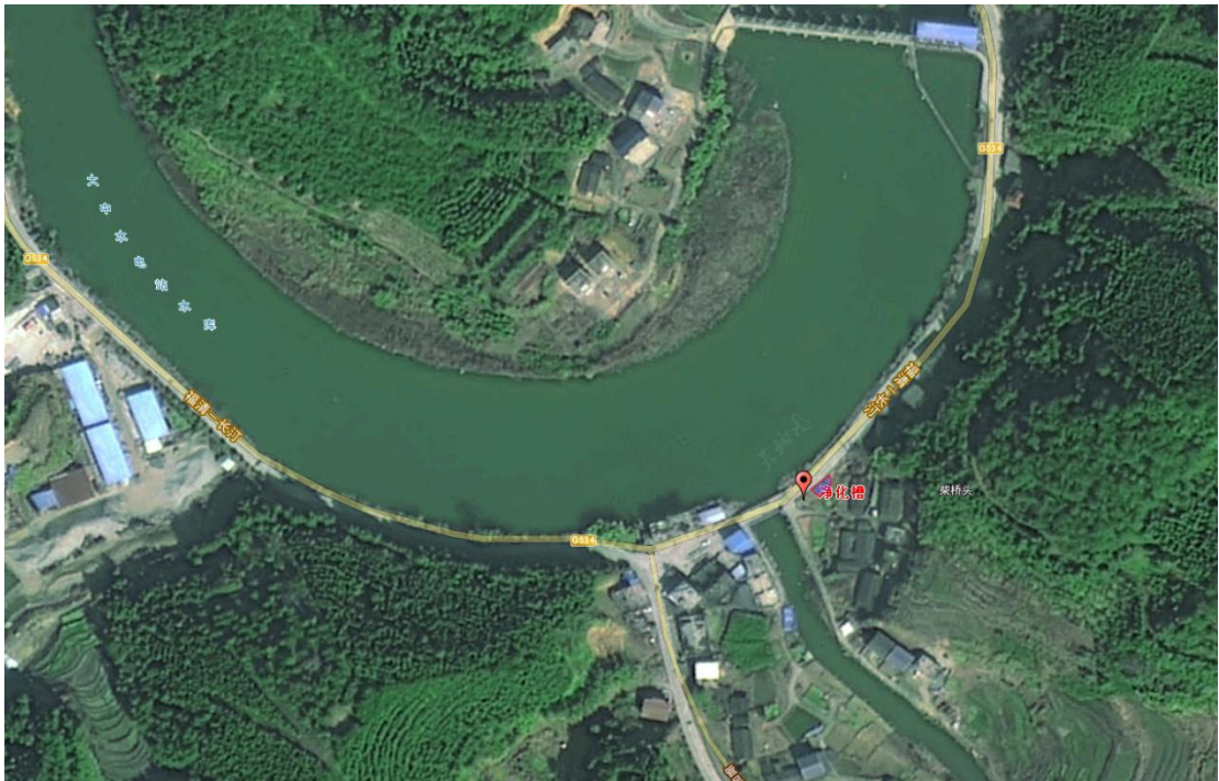
柴桥头净化槽及人工湿地
