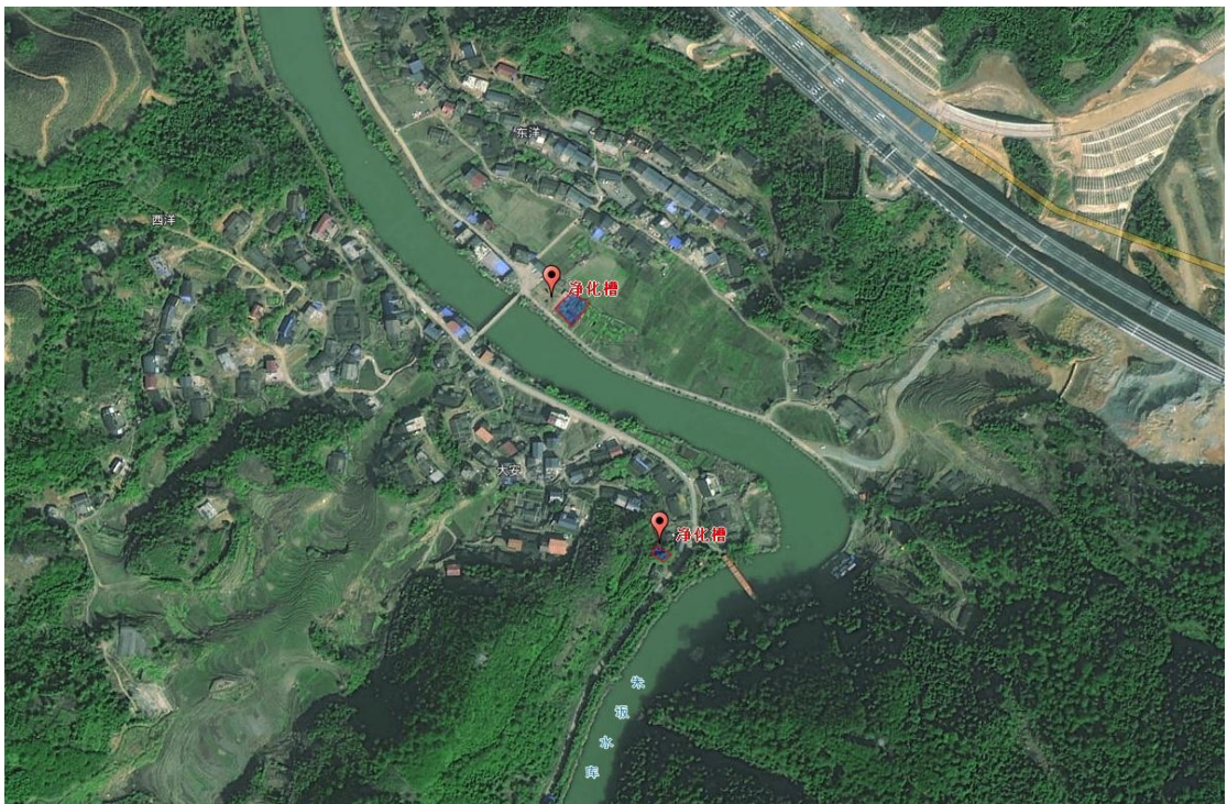
大安村净化槽及人工湿地
