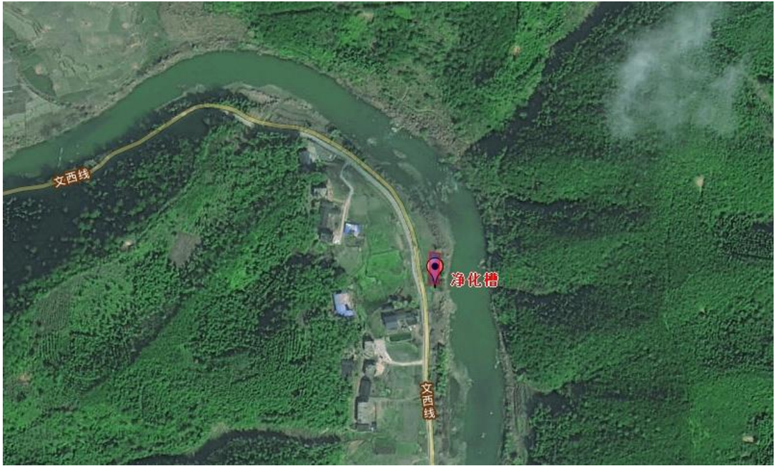
朱坂村净化槽及人工湿地
