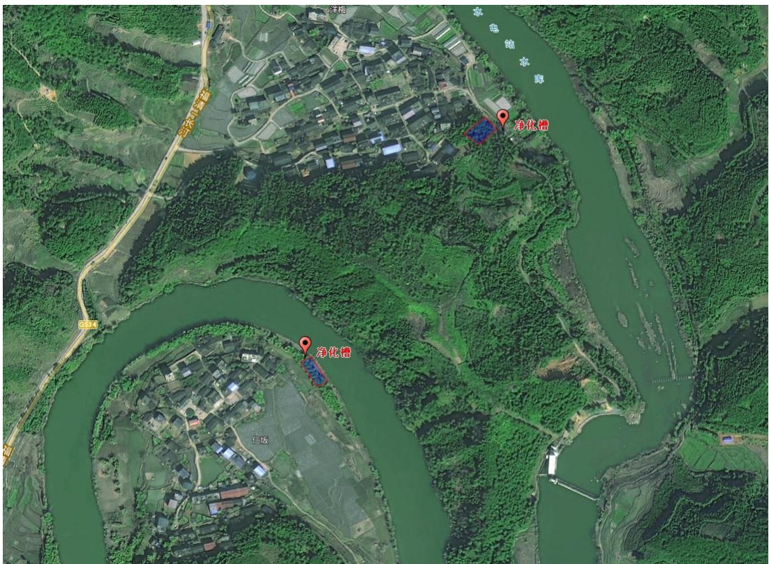
仁坂净化槽及人工湿地
