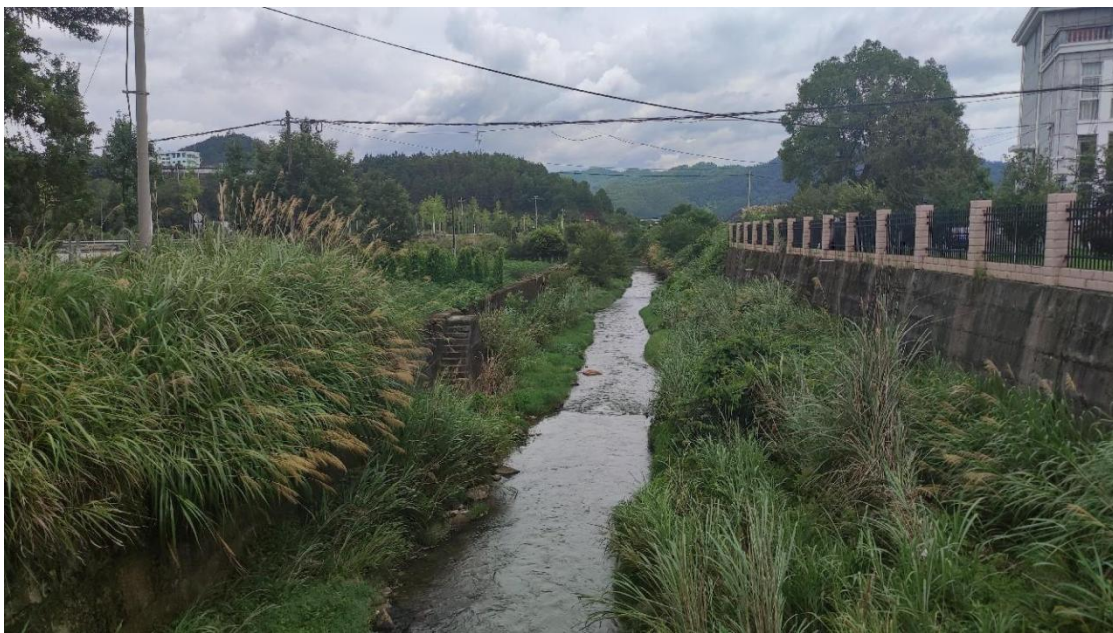
图6.5.1.1-1 南口镇井垵溪河口段现状照片
