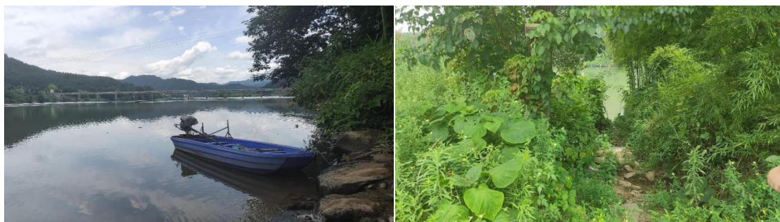
图 6.5.3.6-1 蛟湖渔港码头建设现状
