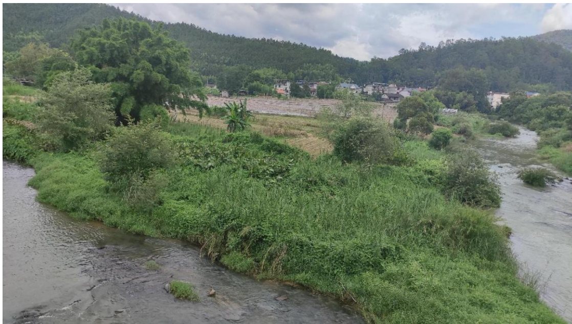
图6.5.1.1-2 南口镇井垵溪河口段现状照片
