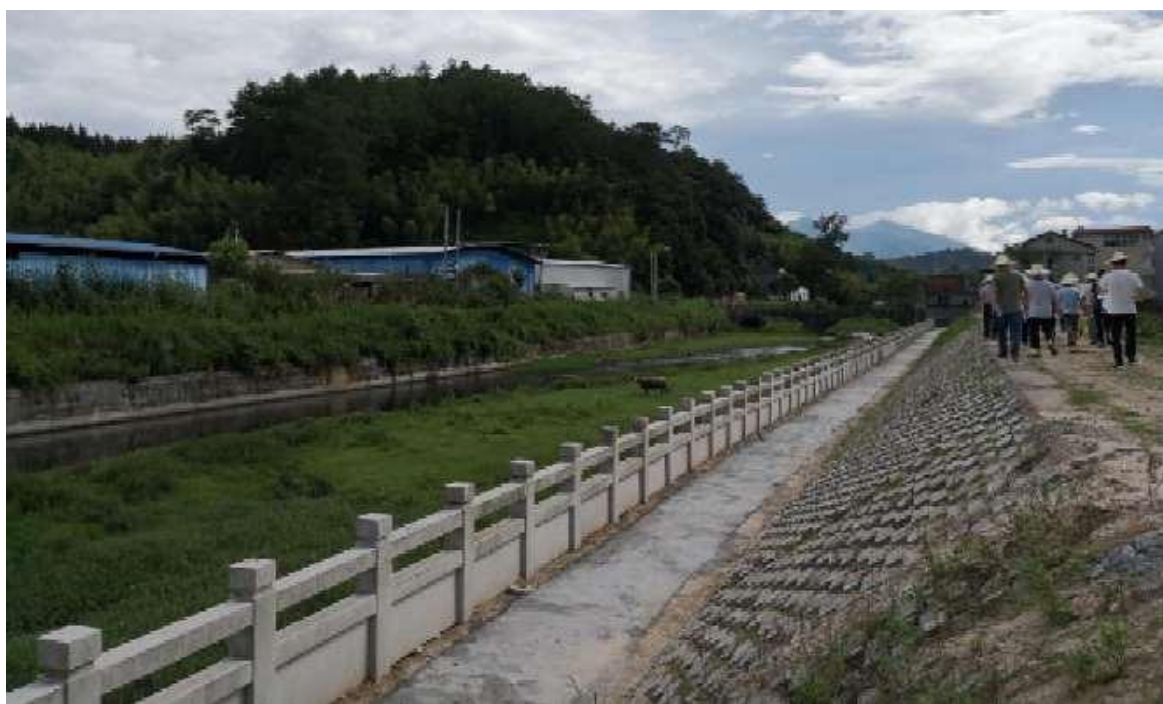
图 4.2.3 将乐县池湖溪白莲段河流治理工程白莲镇区防洪堤
