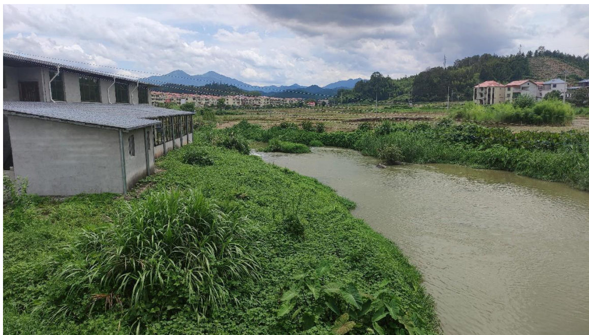
图 6.5.1.1-6 白莲镇池湖溪白莲至洋坊段现状照片
