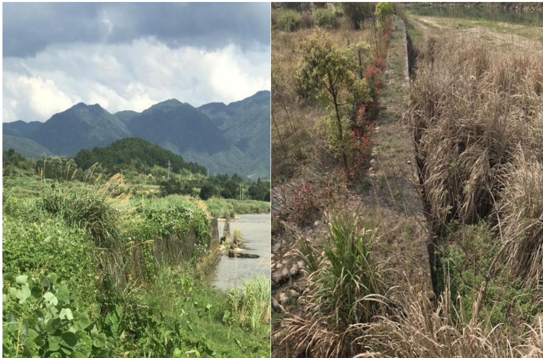
图 4.2.7 池湖溪河道水工措施现状
