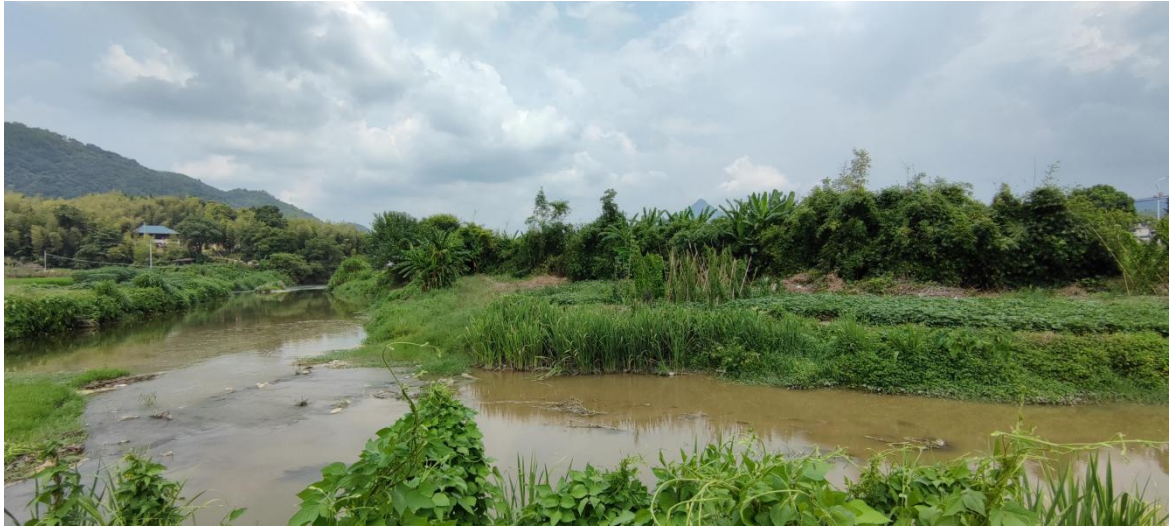
图 4.2.3 池湖溪河道现状
