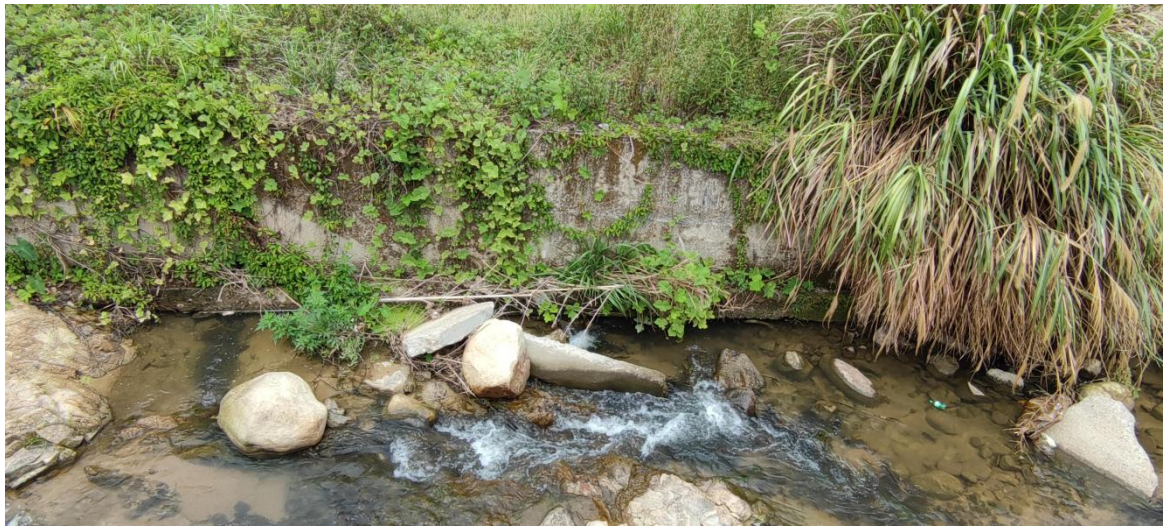
图 4.2.6 池湖溪河道水工措施现状
