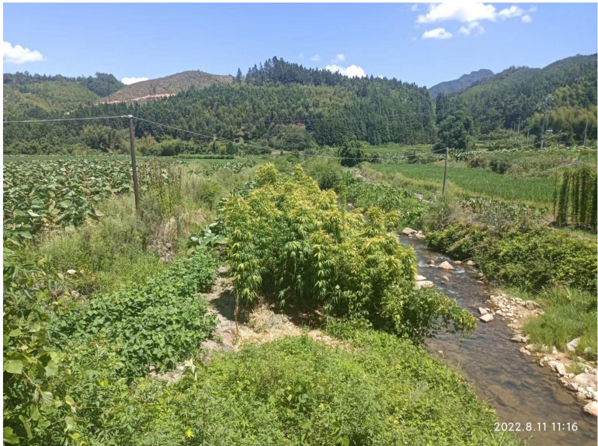
图 4.2.5 池湖溪河道现状
