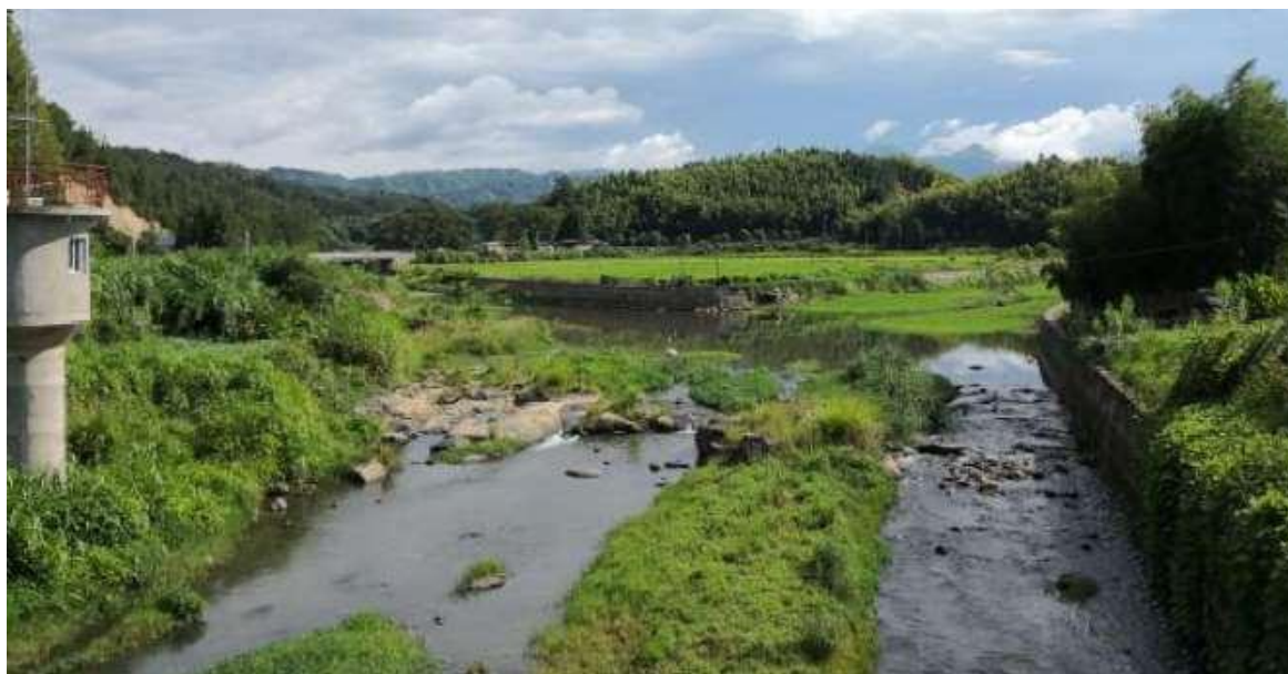
图 4.2.4 将乐县池湖溪白莲段河流治理工程小王溪汇合口护岸
