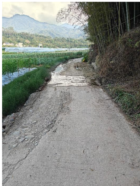
图 3-8 大坡洋水尾山边田间道现状照片
