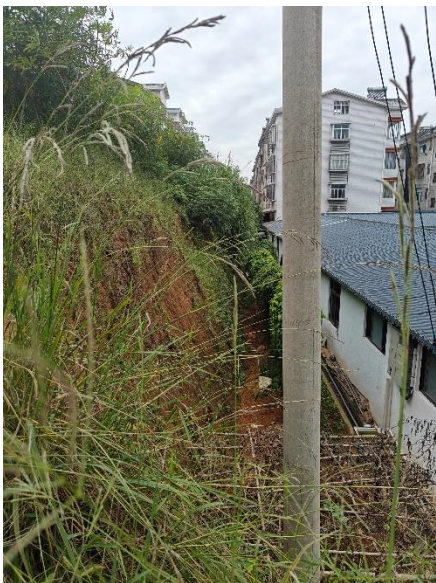
图 3-15 农贸市场挡墙现状照片
