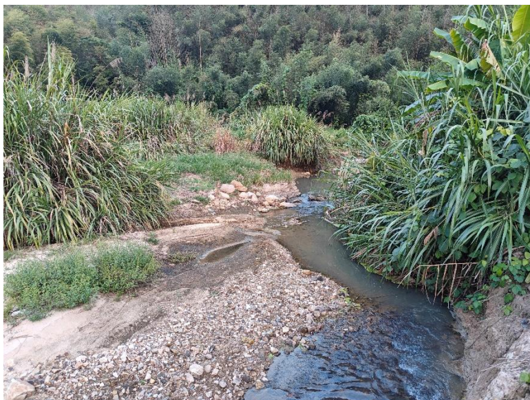
图 3-13 大际板护岸现状照片
