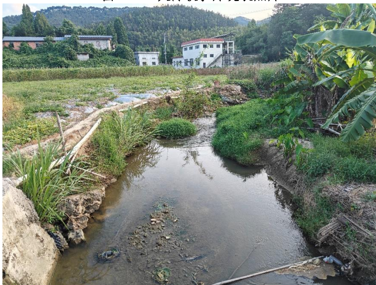
图 3-14 大口电站至半坑护岸现状照片
