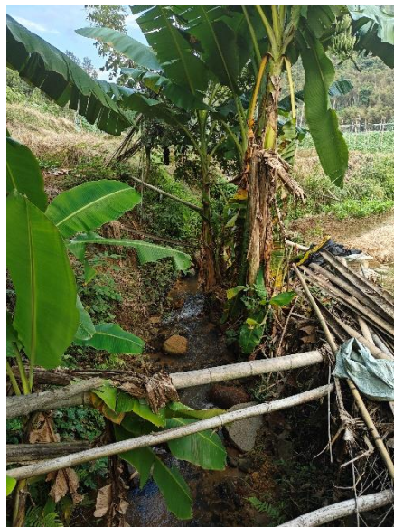
图 3-16 际坂护岸现状照片
