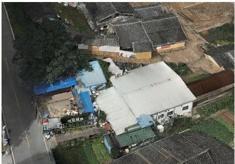
南入口现状照片
