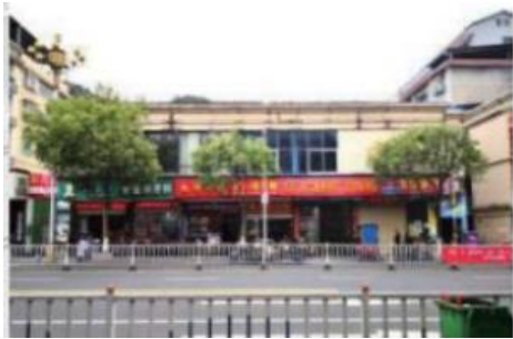
东入口现状照片
