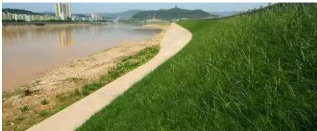
图 5.4-7 植被型生态混凝土护坡示意图
