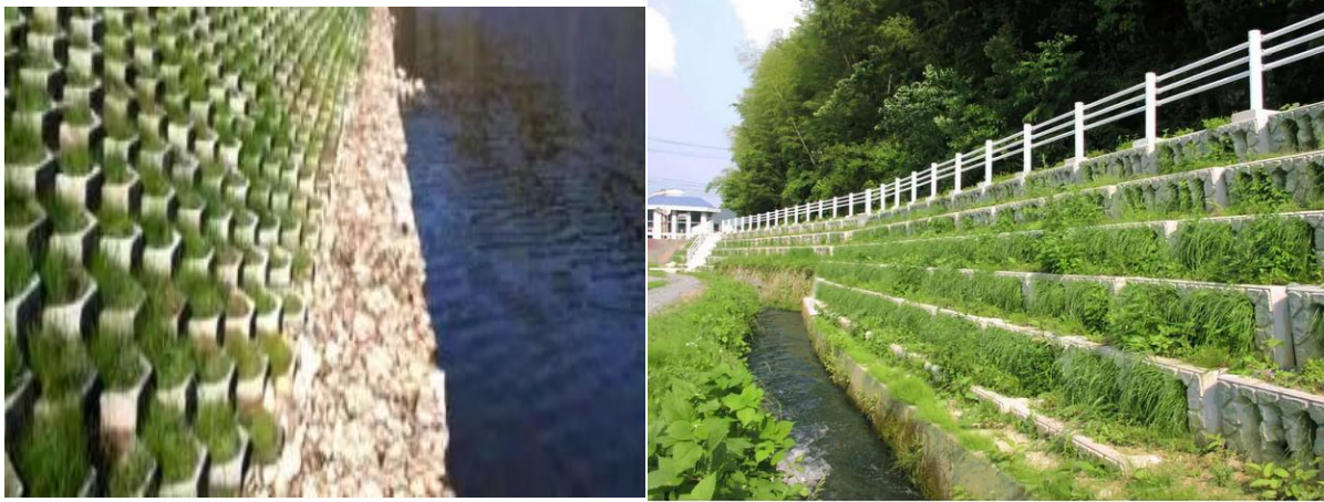
图 5.4-10 自嵌式挡土墙护坡示意图
