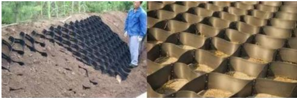
图 5.4-4 土工单元固土种植基护坡示意图
