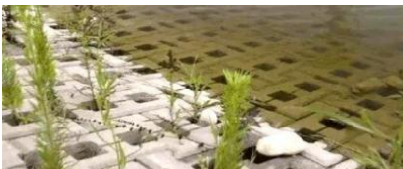
图 5.4-9 多孔结构护坡示意图
