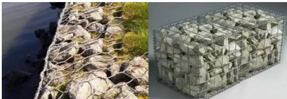
图 5.4-6 生态石笼护坡示意图
