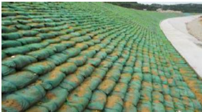
图 5.4-8 生态袋护坡示意图
