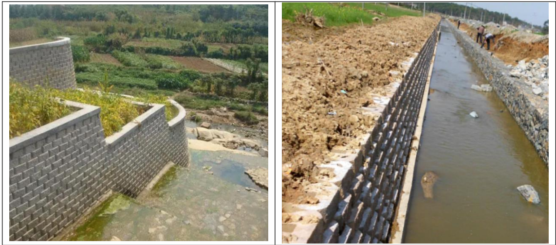
图 5.3-11 自嵌式挡土墙护坡现场示意图
