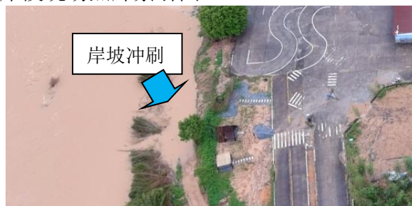
图 4.1-63 乾滩堤段护岸段现场照片二
