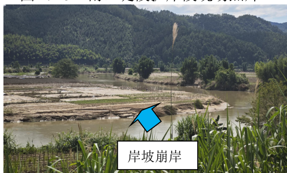
图 4.1-54 南口堤段护岸段现场照片四
