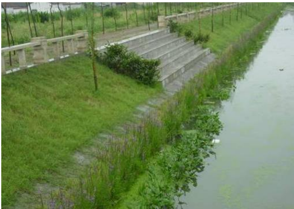
图 5.4-15 C25 生态混凝土护坡
