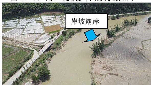
图 4.1-55 南口堤段护岸段现场照片五
