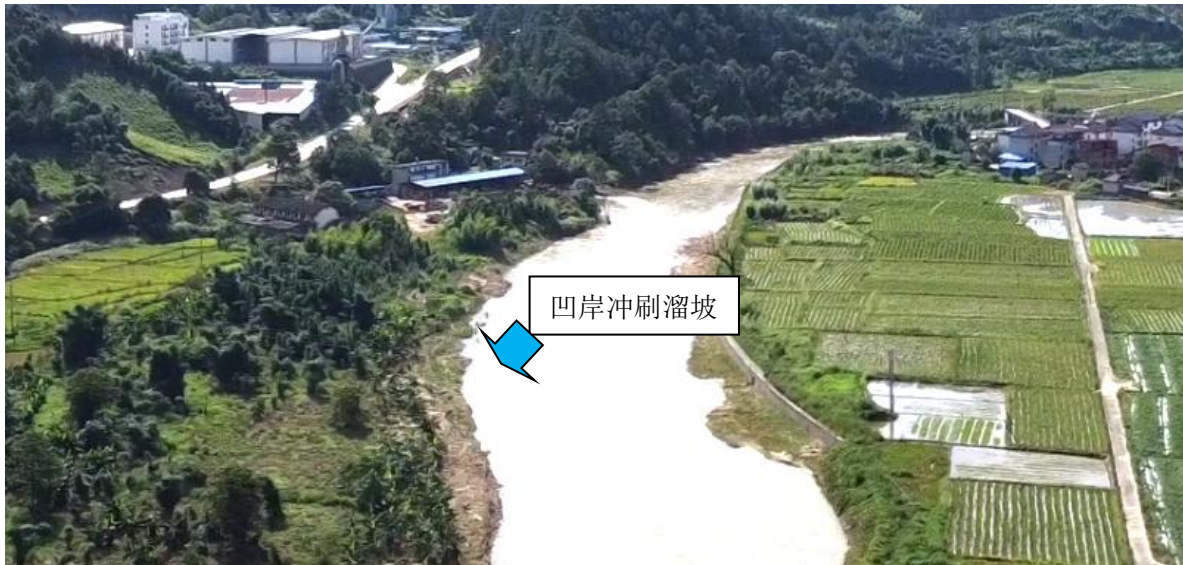
图 4.1-58 积善堤段护岸段现场照片一
