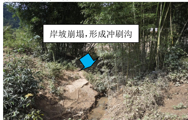
图 4.1-45 乾滩堤段现场照片二
