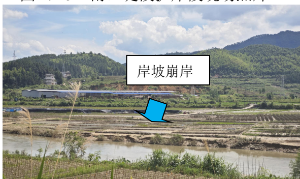
图 4.1-53 南口堤段护岸段现场照片三
