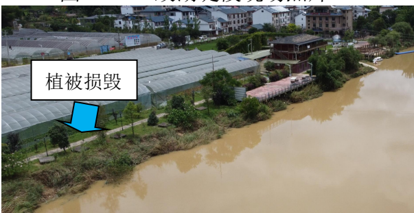
图 4.1-17 蛟湖堤段现场照片四
