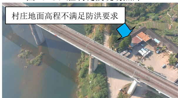
图 4.1-32 胜利堤段现场照片三
