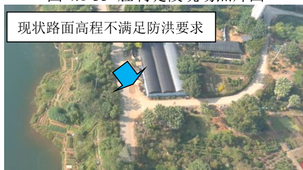
图 4.1-35 胜利堤段现场照片六
