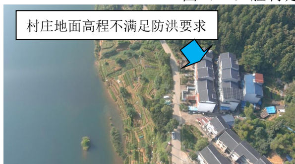
图 4.1-30 胜利堤段现场照片一
