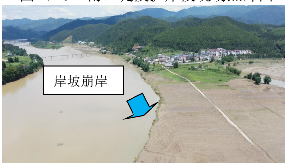
图 4.1-56 南口堤段护岸段现场照片六
