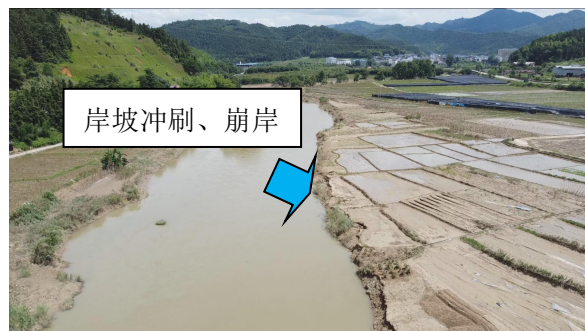
图 4.1-52 南口堤段护岸段现场照片二
