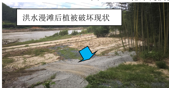
图 4.1-62 乾滩堤段护岸段现场照片一
