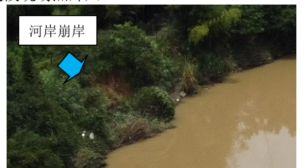
图 4.1-21 蛟湖堤段现场照片八
