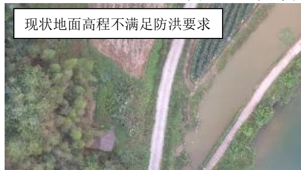
图 4.1-24 大布堤段现场照片一
