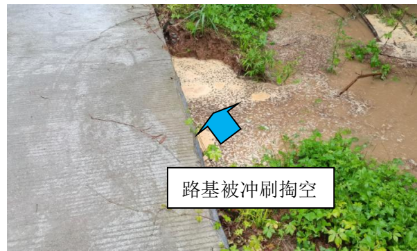
图 4.1-47 乾滩堤段现场照片四
